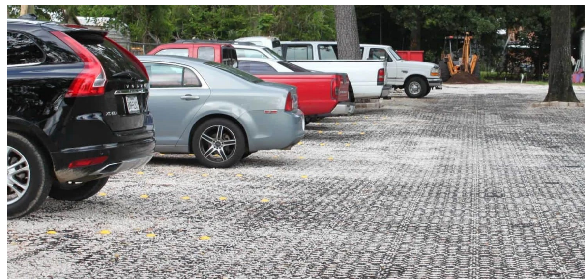
Parcio 1B – Graean gyda grid palmant mandyllog: Arwyneb cadarn a sefydlog sy'n edrych yn naturiol. Mae gridiau plastig yn darparu arwyneb sy'n draenio'n rhwydd ac yn caniatáu i ddŵr glaw dreiddio trwodd i'r is-sylfaen. Mae gridiau plastig hefyd yn caniatáu gosod marcwyr i ffurfioli cilfachau parcio yn ystod y tymor brig y gellir eu tynnu ymaith unrhyw bryd.
