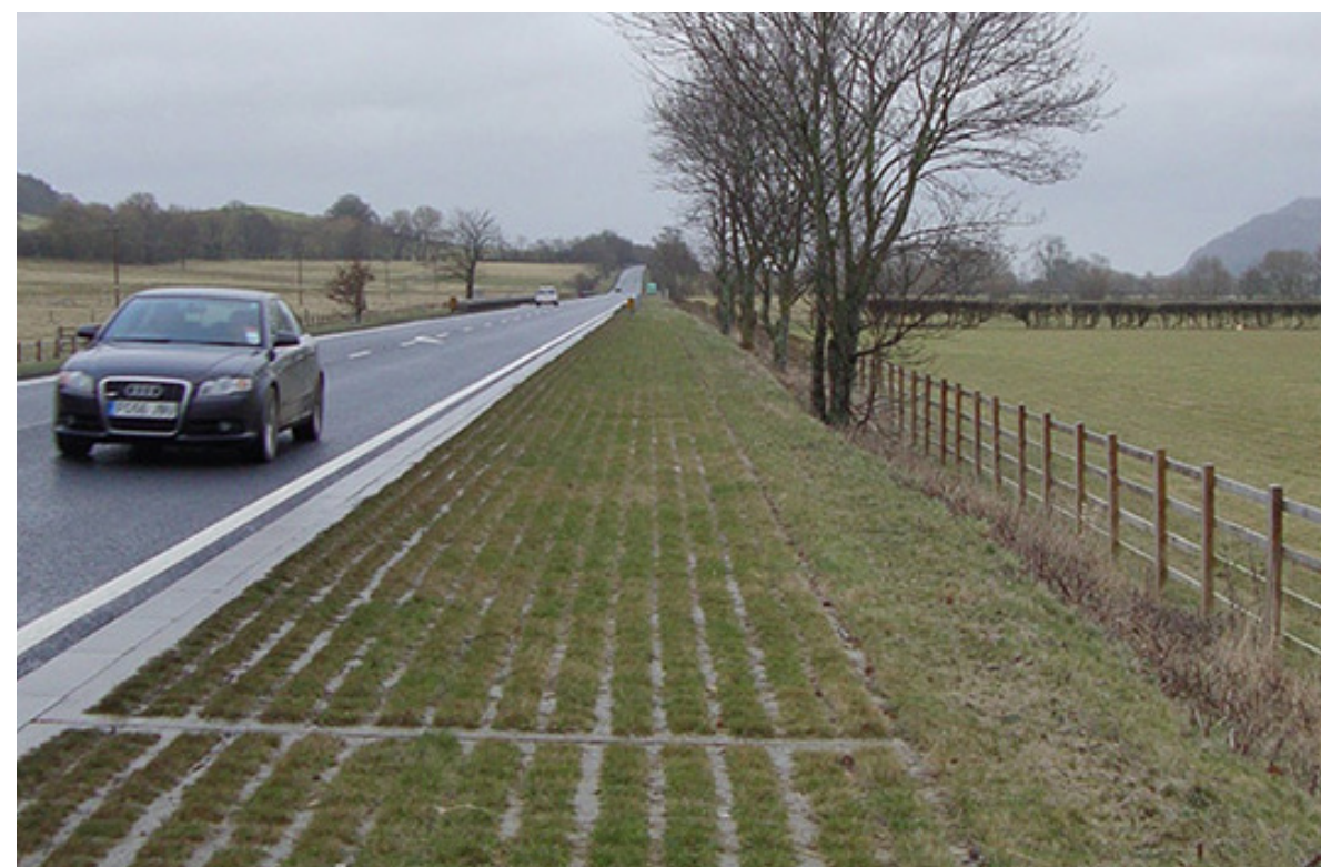
Parcio 1A – Parcio Grât-laswellt: Arwyneb parcio arwahanol a naturiol yr olwg y gellir ei osod ar ymylon ffyrdd.
