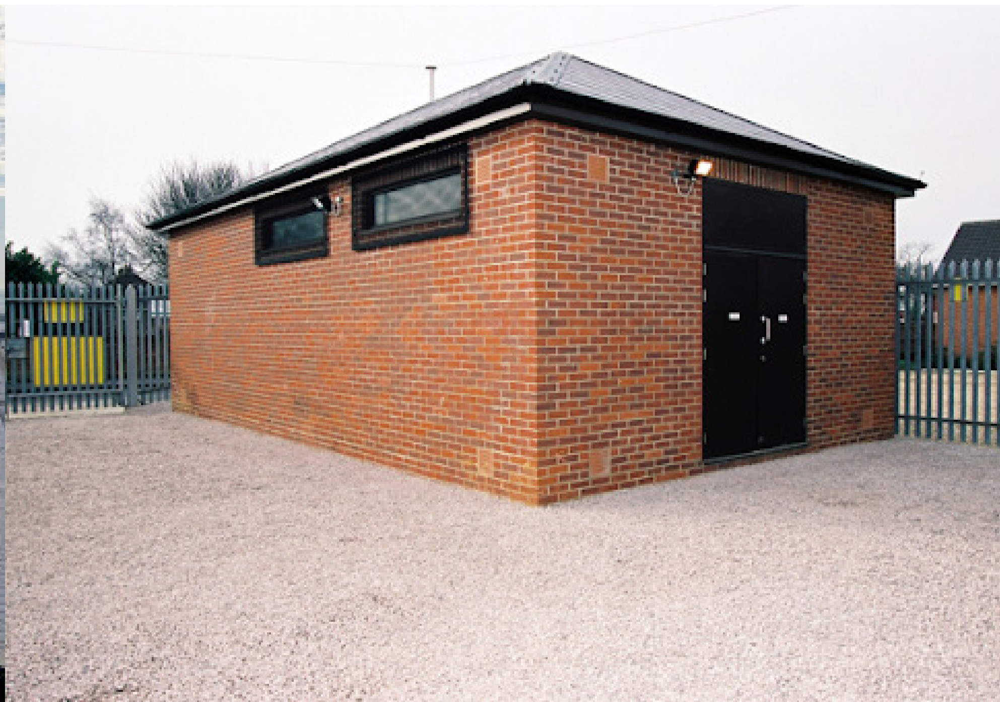
Is-orsaf Gweithredwr Rhwydwaith Ardal / DNO Substations
